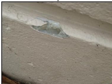
Photo N° 3206 ECH-N°25 -BAT 177-277 pignons Murs soubassement béton+peinture
