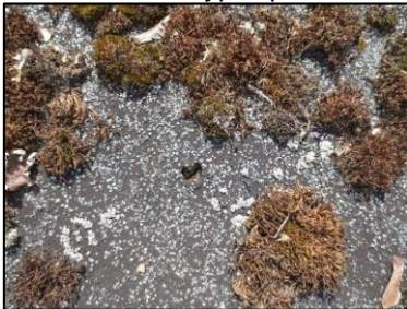
Photo N° 3228 ECH-N°42 -BAT 177-277 Toiture terrasse Etanchéité bitume
