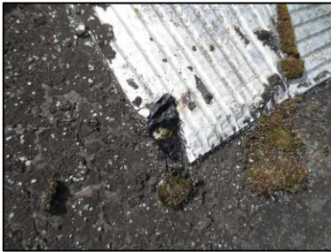
Photo N° 3222 ECH-N°37 - BAT113-157 Toiture terrasse Etanchéité type "paxalu"
