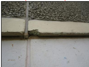
Photo N° 3241 ECH-N°52 - BAT113-157 pignons Murs béton+peinture
