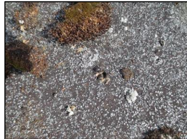
Photo N° 3229 ECH-N°44 -BAT 177-277 Toiture terrasse Etanchéité bitume
