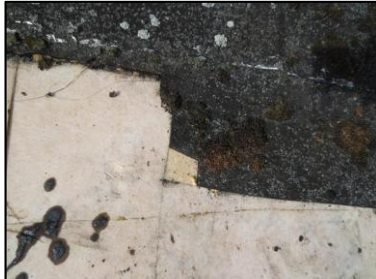
Photo N° 3219 ECH-N°34 - BAT113-157 Toiture terrasse Etanchéité bitume
