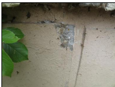
Photo N° 3200 ECH-N°20 -BAT 177-277 pignons Murs soubassement béton+peinture
