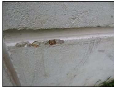
Photo N° 3240 ECH-N°51 - BAT113-157 pignons Murs soubassement béton+peinture
