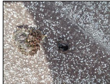
Photo N° 3230 ECH-N°46 -BAT 177-277 Toiture terrasse Etanchéité bitume
