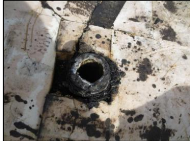
Photo N° 3216 ECH-N°31 AMIANTE CIMENT -BAT113-157 Toiture Conduit (Fibres-ciment)
