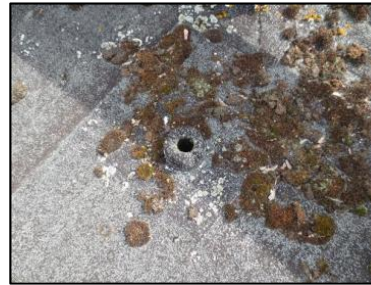
Photo N° 3236 ECH-N°48 AMIANTE CIMENT -BAT 177-277 Toiture terrasse Conduit (Fibres-ciment)
