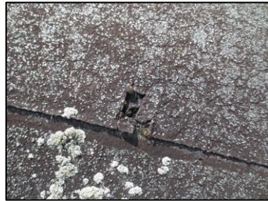
Photo N° 3223 ECH-N°38 - BAT113-157 Toiture terrasse Etanchéité bitume
