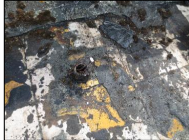
Photo N° 3217 ECH-N°32 AMIANTE CIMENT -BAT113-157 Toiture Conduit (Fibres-ciment)
