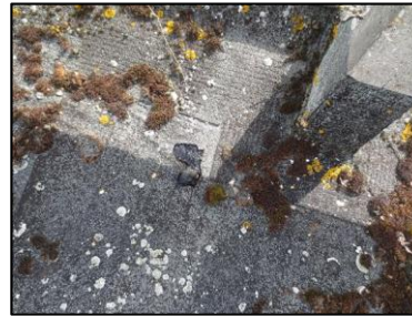
Photo N° 3227 ECH-N°40 -BAT 177-277 Toiture terrasse Etanchéité bitume
