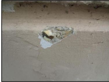
Photo N° 3212 ECH-N°28 - BAT113-157 pignons Murs soubassement béton+peinture
