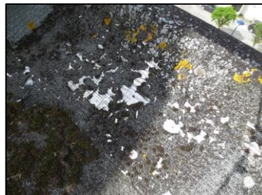
Photo N° 3232 ECH-N°41 -BAT 177-277 Toiture terrasse Etanchéité type "paxalu"
