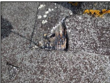
Photo N° 3231 ECH-N°39 -BAT 177-277 Toiture terrasse Etanchéité type "paxalu"
