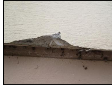
Photo N° 3214 ECH-N°30 - BAT113-157 pignons Murs béton+peinture
