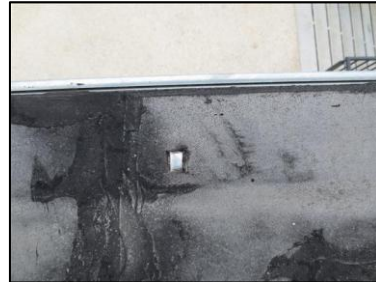
Photo N° 3177 ECH-N°05 -BAT 86-190 pignons Toiture local Revêtement bitumineux
