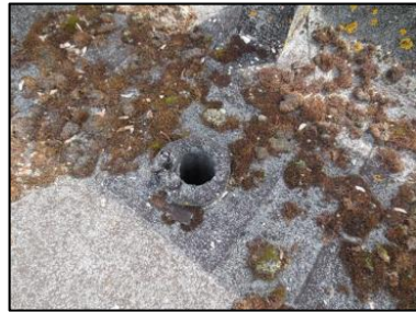
Photo N° 3235 ECH-N°47 AMIANTE CIMENT -BAT 177-277 Toiture terrasse Conduit ventilation (Fibres-ciment)
