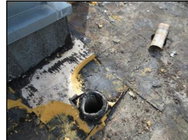
Photo N° 3221 ECH-N°36 AMIANTE CIMENT -BAT113-157 Toiture terrasse Conduit ventilation (Fibres-ciment)
