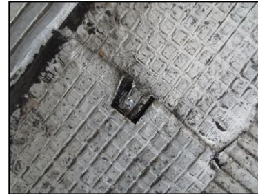
Photo N° 3178 ECH-N°06 -BAT 86-190 pignons Toiture local Etanchéité type "paxalu"
