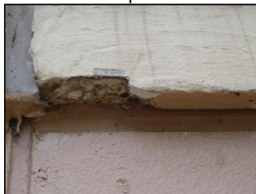
Photo N° 3205 ECH-N°24 -BAT 177-277 pignons Murs béton+peinture
