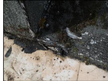
Photo N° 3218 ECH-N°33 - BAT113-157 Toiture terrasse Etanchéité type "paxalu"
