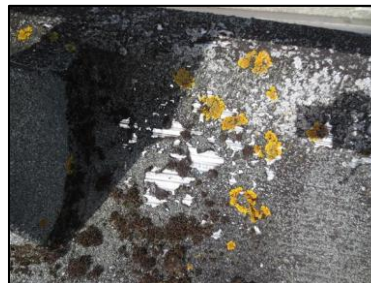
Photo N° 3233 ECH-N°43 -BAT 177-277 Toiture terrasse Etanchéité type "paxalu"
