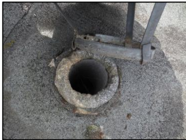
Photo N° 3237 ECH-N°49 AMIANTE CIMENT -BAT 177-277 Toiture terrasse Conduit ventilation (Fibres-ciment)
