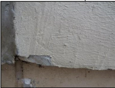
Photo N° 3194 ECH-N°16 -BAT 32-210 pignons Murs béton+peinture
