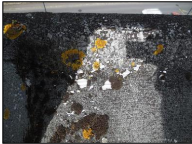
Photo N° 3234 ECH-N°45 -BAT 177-277 Toiture terrasse Etanchéité type "paxalu"
