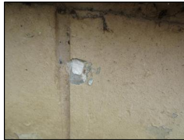
Photo N° 3196 ECH-N°18 -BAT 32-210 pignons Murs soubassement béton+peinture
