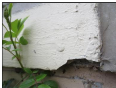
Photo N° 3201 ECH-N°21 -BAT 177-277 pignons Murs béton+peinture
