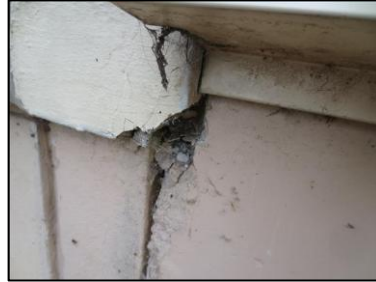
Photo N° 3172 ECH-N°02 -BAT 86-190 pignons Murs soubassement béton+peinture
