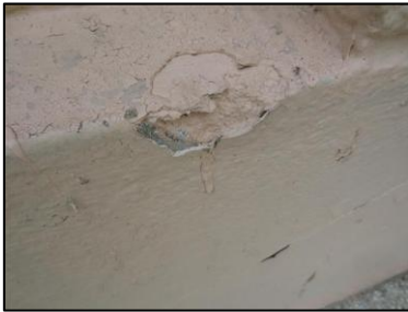
Photo N° 3183 ECH-N°10 -BAT 86-190 pignons Murs soubassement local béton+peinture
