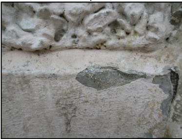
Photo N° 3190 ECH-N°13 -BAT 32-210 pignons Murs soubassement béton+peinture
